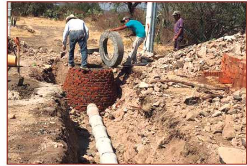
Ampliación de red de drenaje sanitario
