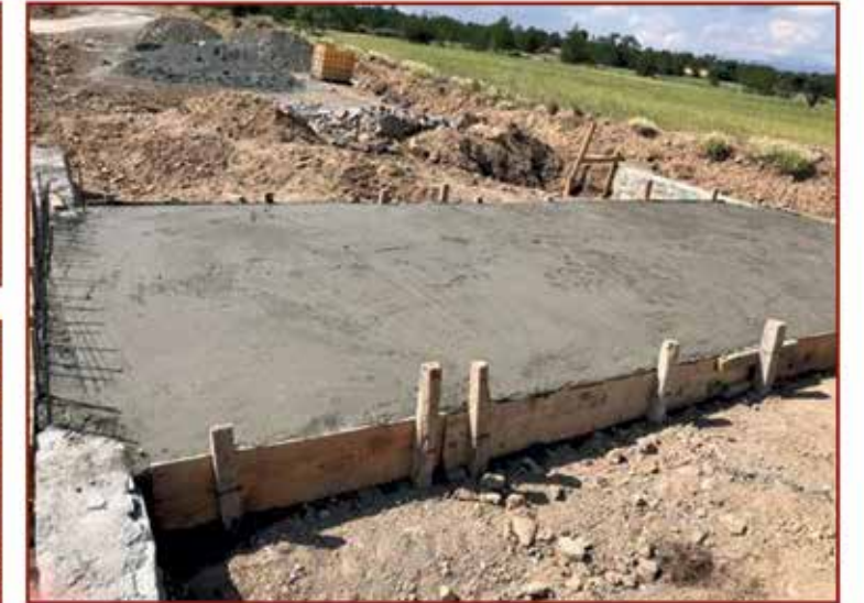
Construcción de 5 puentes carreteros en el Camino Santa Clara-El Cerrito tramo Ejido Tlaquilpan.
