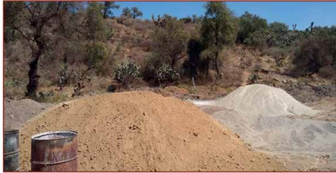
Construcción de drenaje sanitario a fosa
