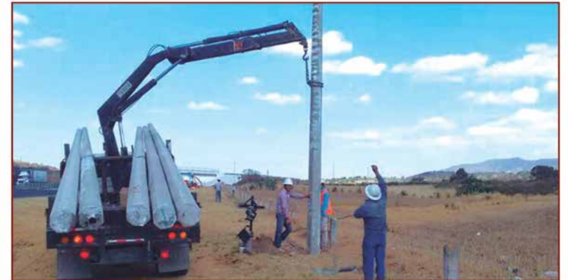
Ampliación de red de electrificación
