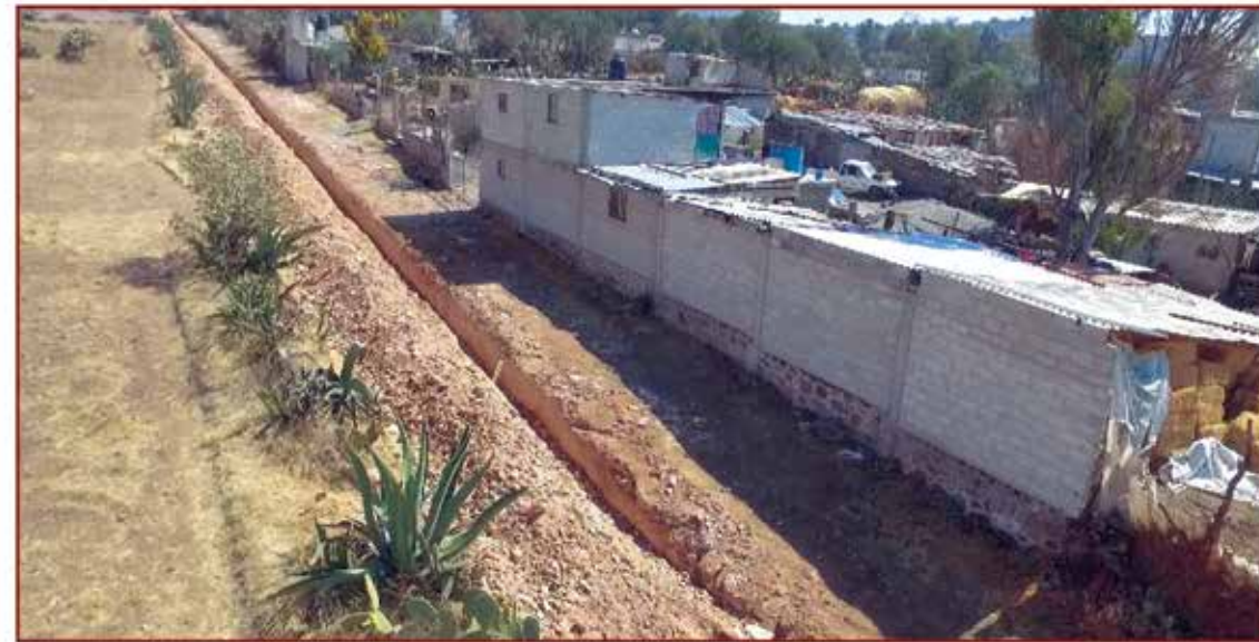
Ampliación de red de drenaje sanitario
