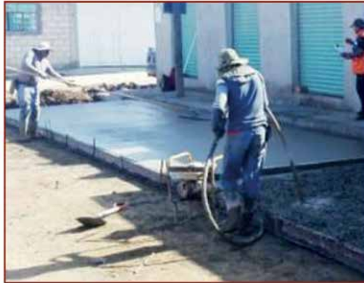
Pavimentación hidráulica en calle Solidaridad
