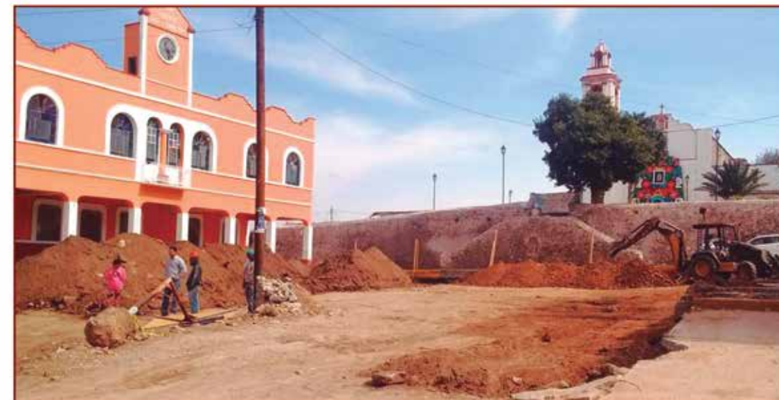
Construcción de parque recreativo
