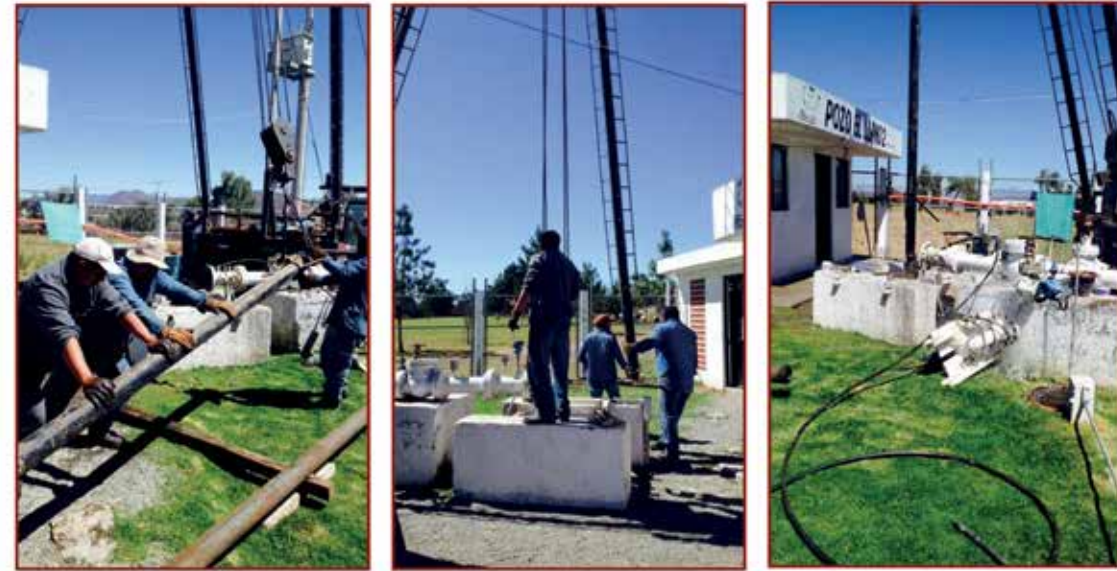
Rehabilitación de sistema de agua potable
