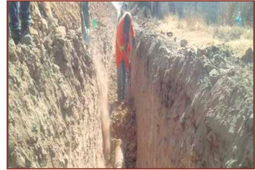
Ampliación de red de drenaje sanitario
