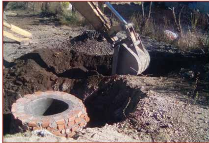
Ampliación de red de drenaje sanitario
