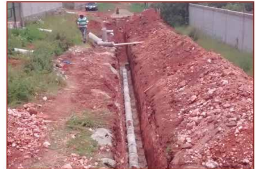
Ampliación de red de drenaje sanitario
