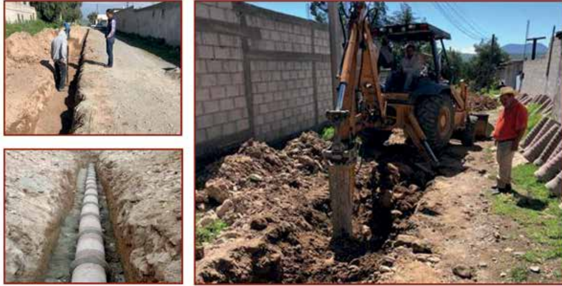
Ampliación de red de drenaje sanitario
