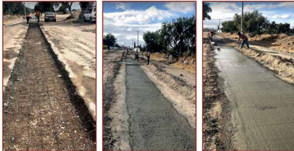
Reposición de pavimento de drenaje CECYTEH
