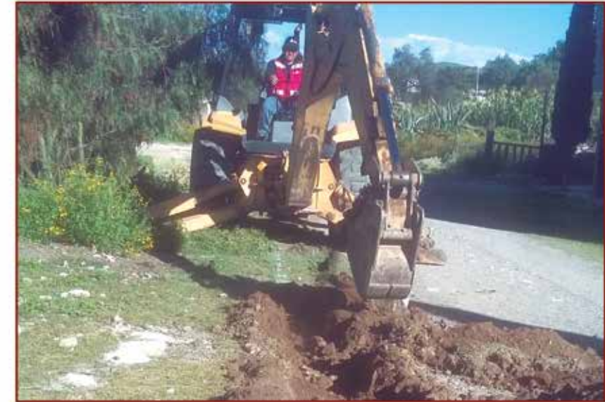
Ampliación de red de agua potable
