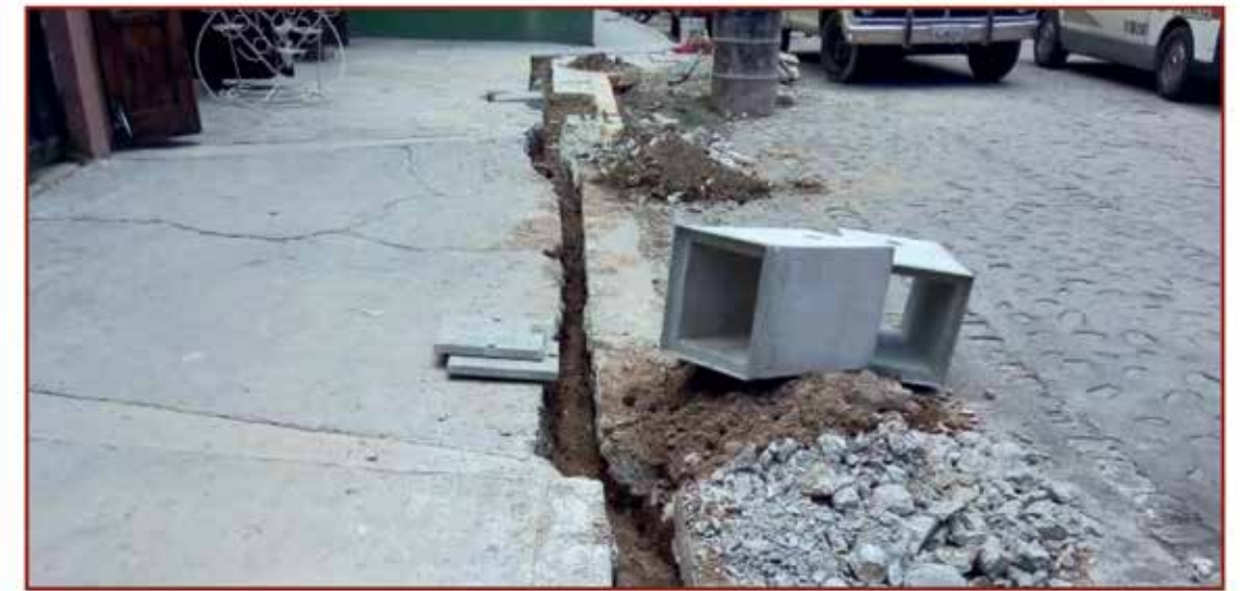
Conversión de red de distribución de energía eléctrica aérea a subterránea en el Centro Histórico de Zempoala
