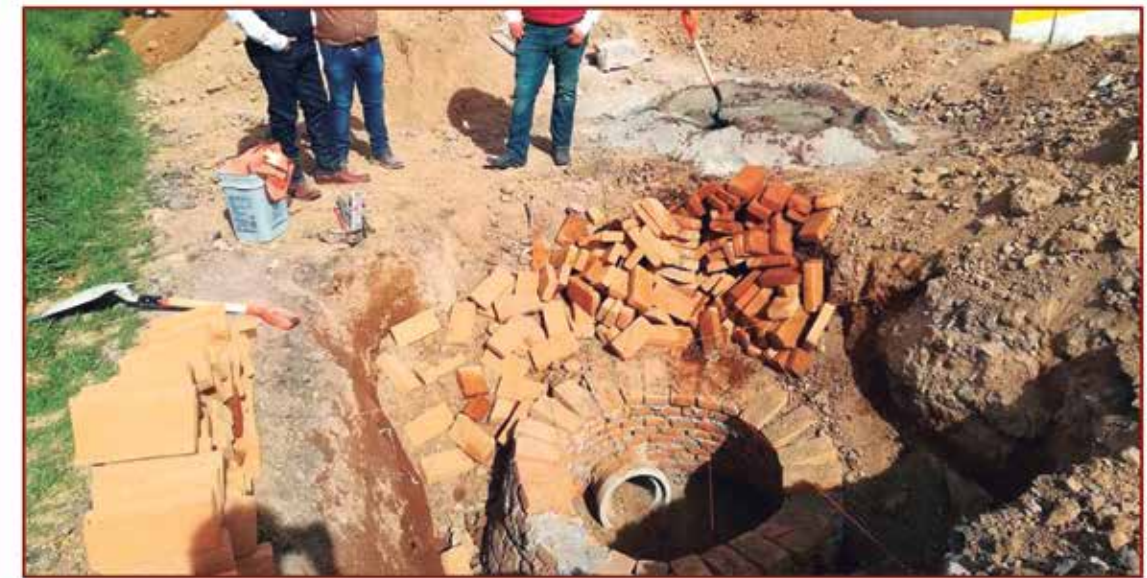
Ampliación de red de drenaje sanitario
