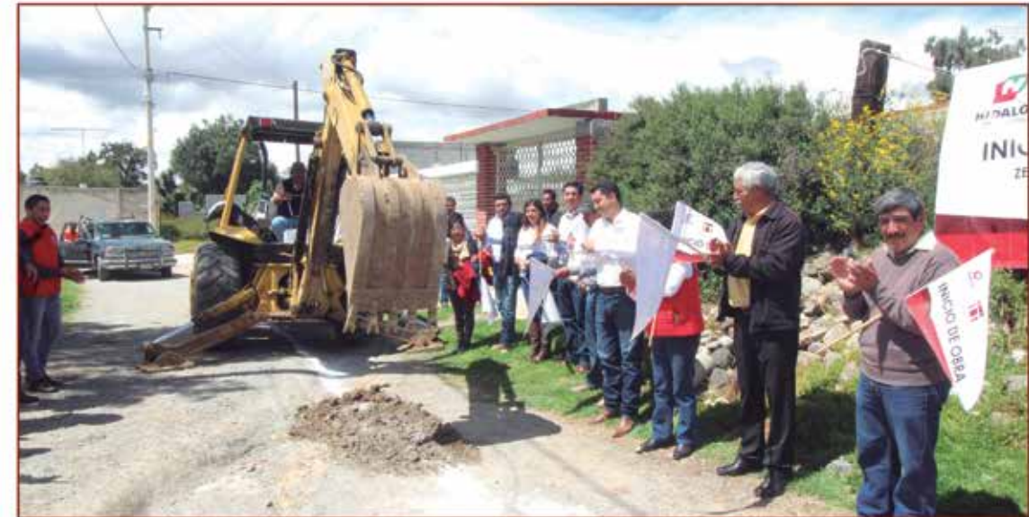
Ampliación de red de drenaje sanitario
