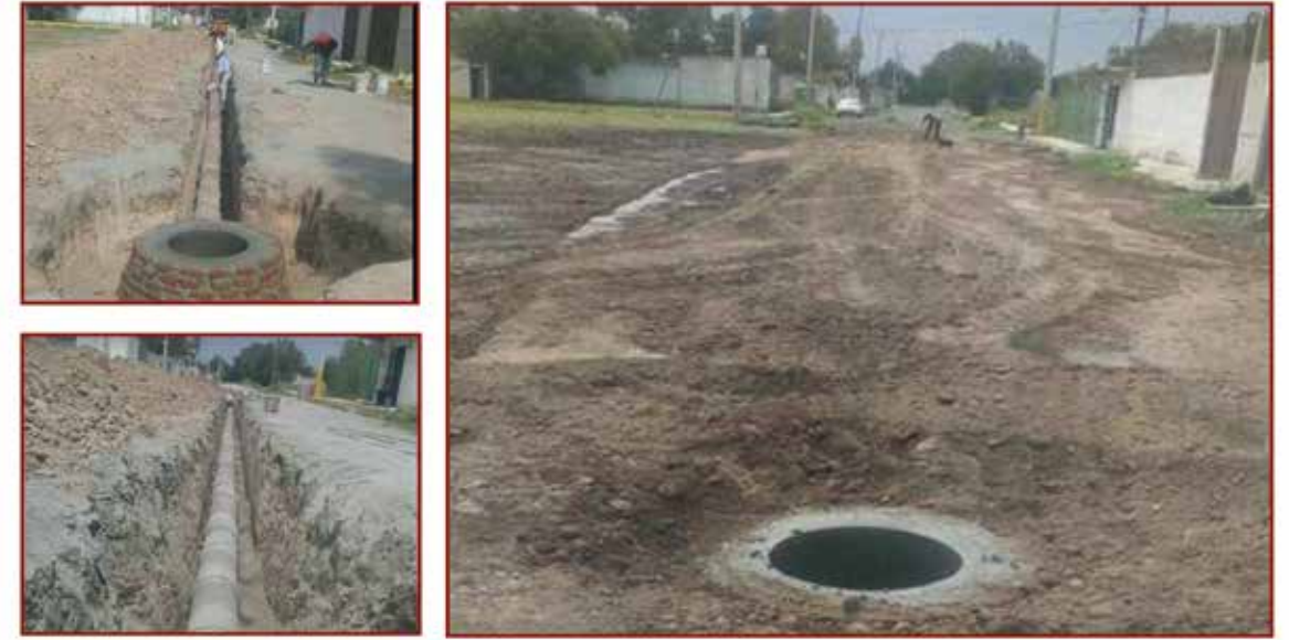
Ampliación de red de drenaje sanitario
