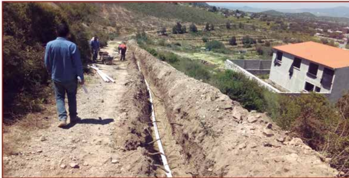
Ampliación de red de agua potable. Etapa 2
