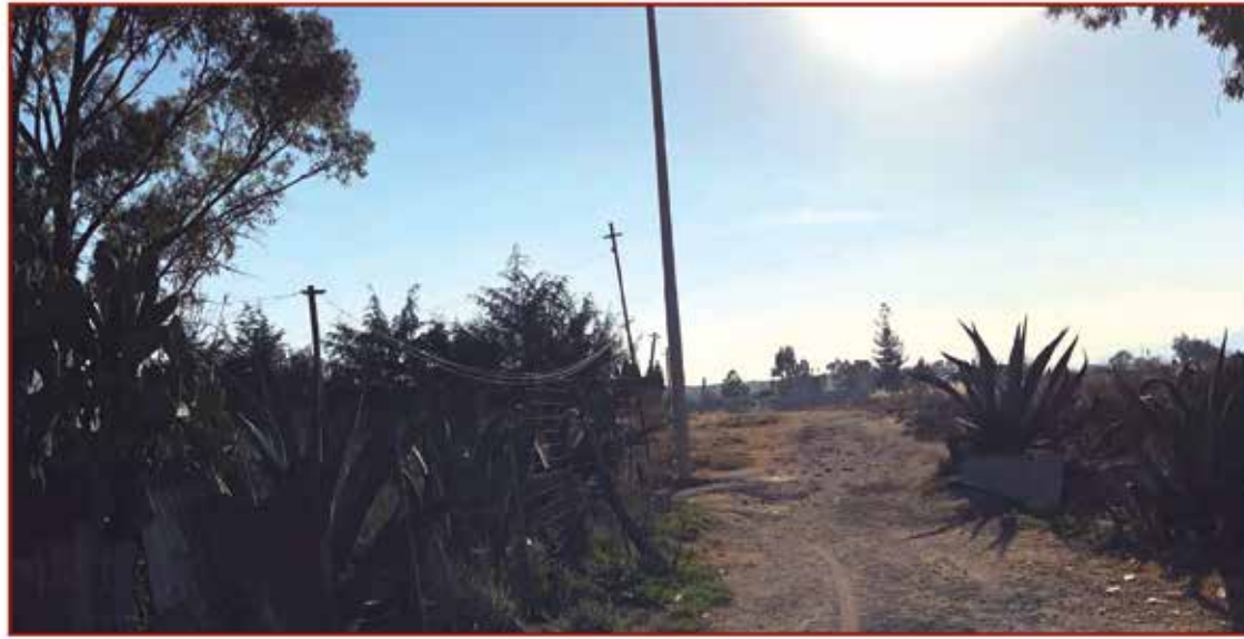
Ampliación de red de electrificación
