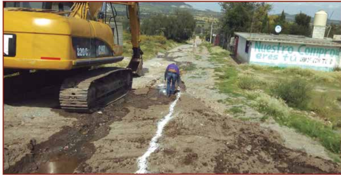
Ampliación de red de drenaje sanitario
