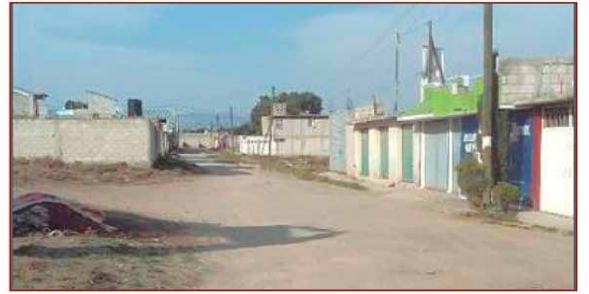
Ampliación de red de electrificación
