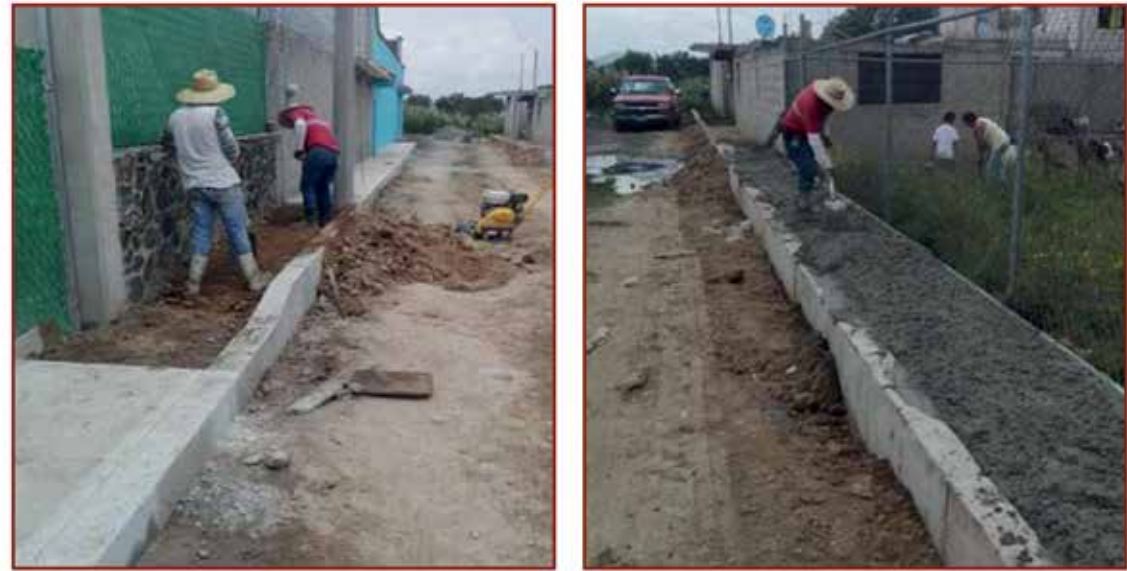
Construcción de guarniciones y banquetas
