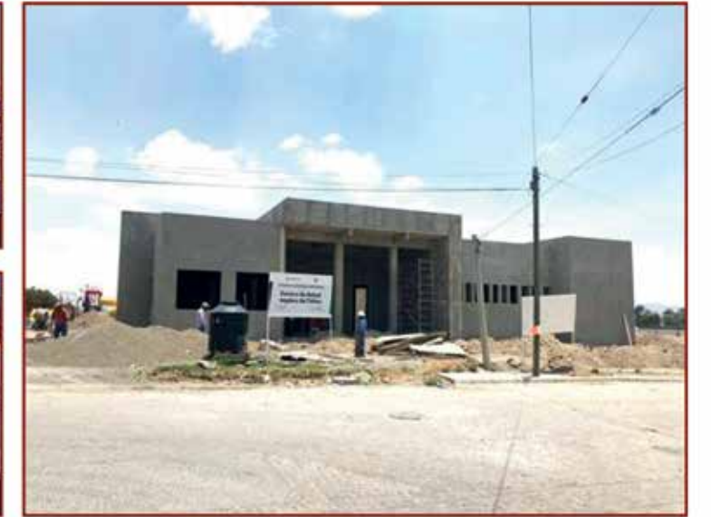
Construcción de Centro de Salud
