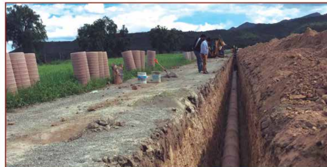
Ampliación de red de drenaje sanitario
