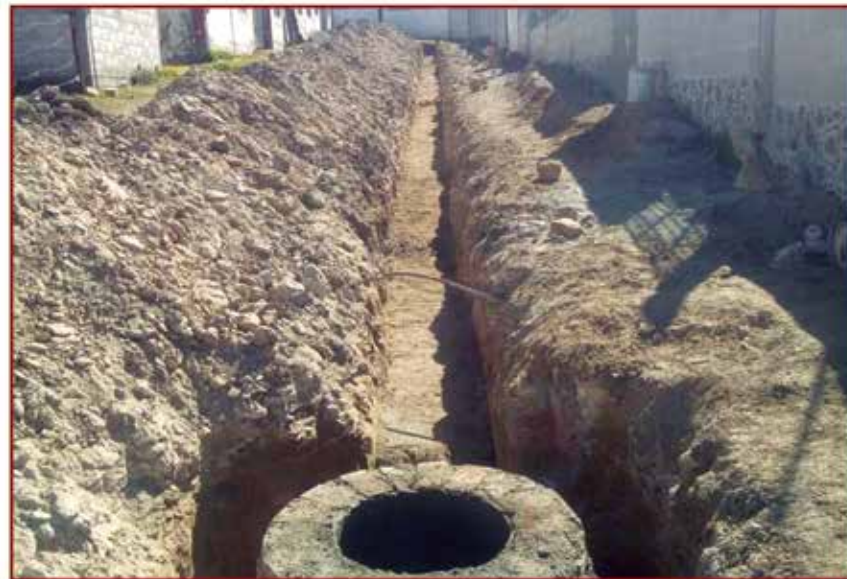
Ampliación de red de drenaje sanitario
