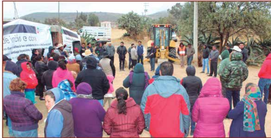
Ampliación de red de drenaje sanitario
