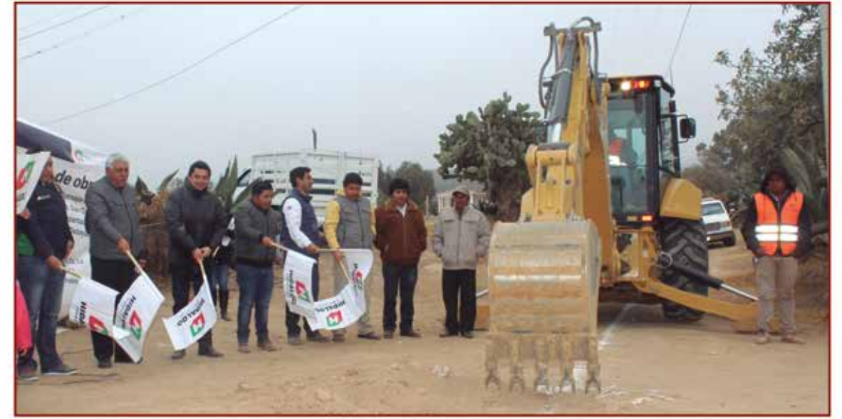
Ampliación de red de drenaje sanitario
