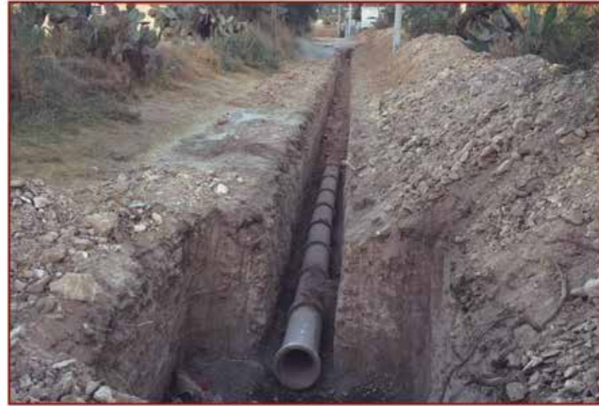
Ampliación de red de drenaje sanitario
