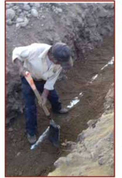
Línea de conducción de agua potable
