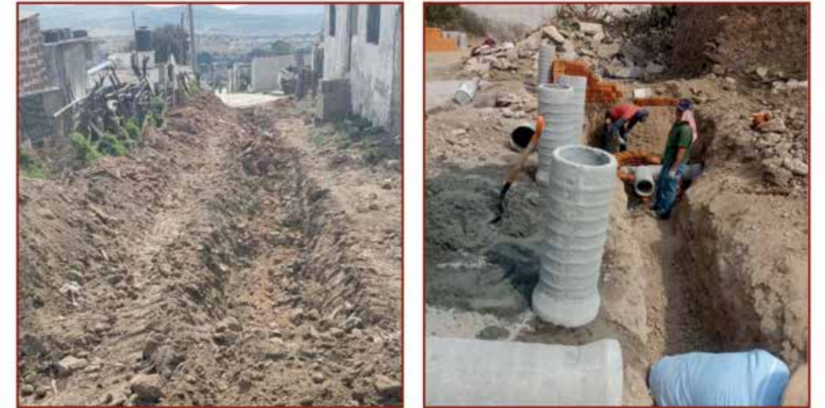
Ampliación de red de drenaje sanitario
