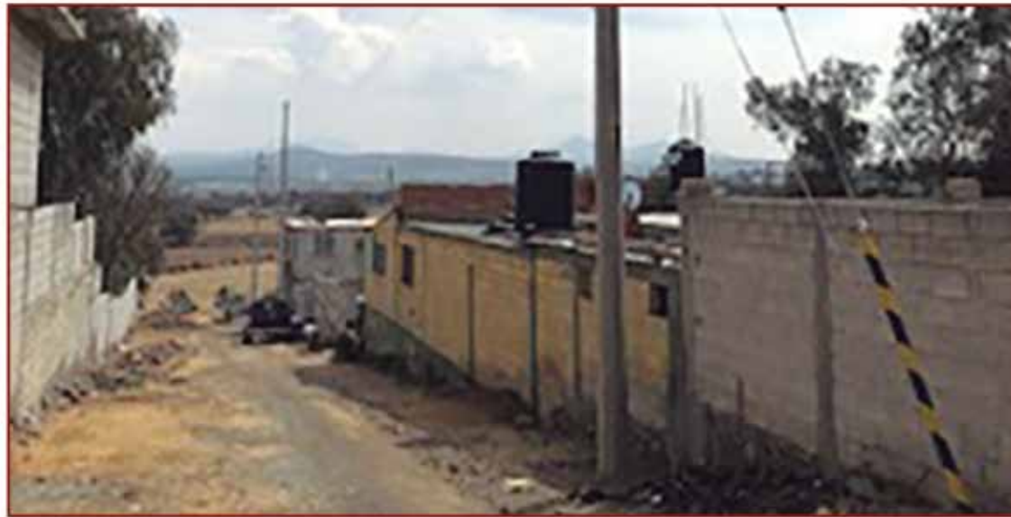
Ampliación de red de electrificación
