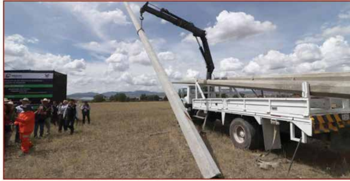
Electrificación en calle Fraternidad, Autonomía, Mirasoles, Av. Pirules y El Cerrito)
