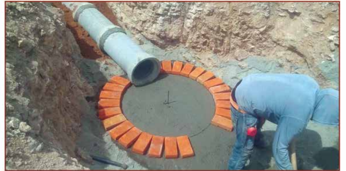
Ampliación de red de drenaje sanitario
