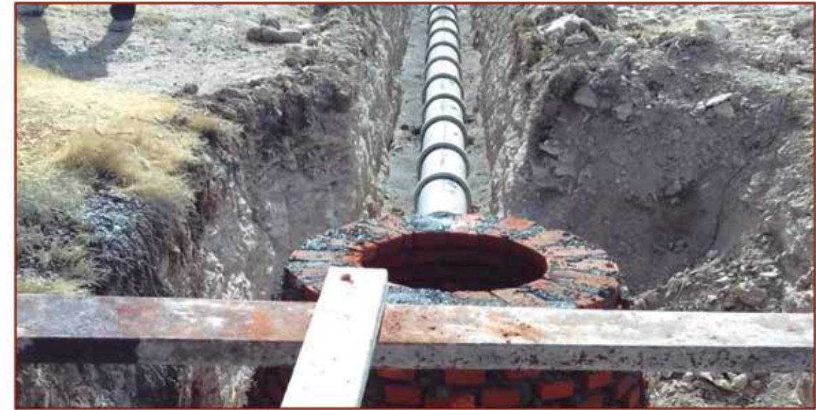
Ampliación de red de drenaje sanitario
