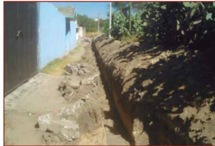
Ampliación de red de drenaje sanitario
