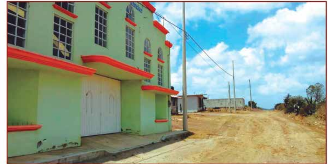
Ampliación de red de electrificación
