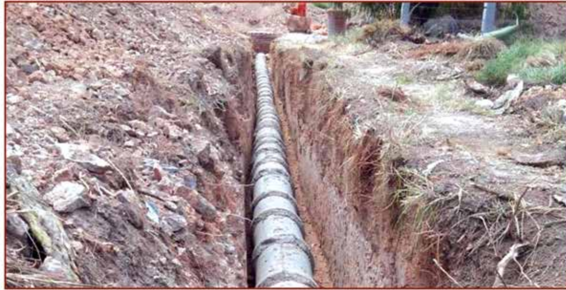
Ampliación de red de drenaje sanitario
