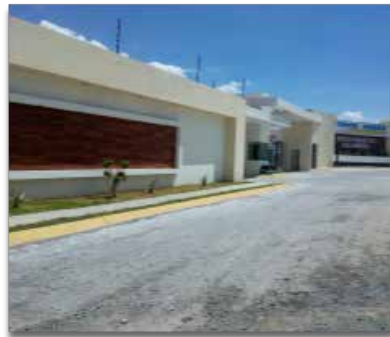
2 Rinconadas de Villarreal
