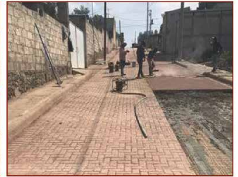
Pavimentación hidráulica en calle Autonomía
