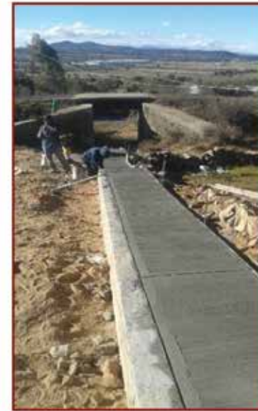
Construcción de guarniciones y banquetas en calle Eucalipto
