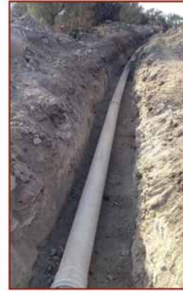
Línea de conducción de agua potable
