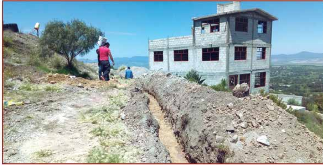
Ampliación de red de agua potable. Etapa 1
