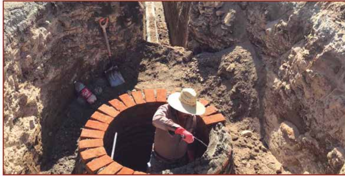
Construcción de sistema de alcantarillado sanitario, primera etapa
