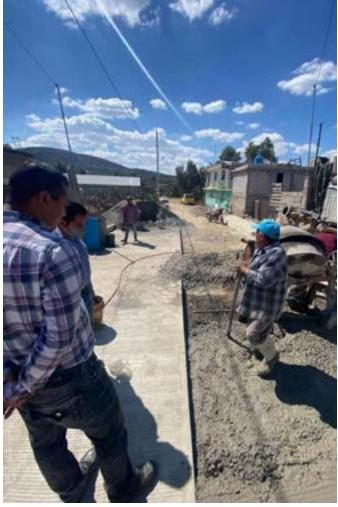
También invertimos \$600,000 pesos del Fondo FAISM 2021 donde se construyeron 491.83 metros cuadrados de pavimento hidráulico, 162.05 metros lineales de guarniciones y banquetas, así como la aplicación de 159.11 metros lineales de pintura tráfico con una inversión de \$50,950 pesos para la rehabilitación de caminos de terracería, de esta manera entregamos a la población vías dignas para su tránsito.
