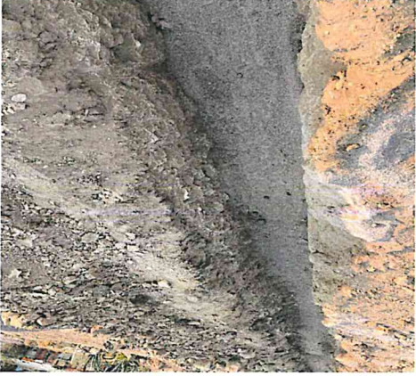
INSTALACION DE TUBERIA Y POZOS DE VISITA CAMA DE ARENA, APISONADA CON PISON DE MANO, INCLUYE CONSTRUCCION DE APOYO SEMICIRCULAR PARA PERMITIR APOYO COMPLETO DE LA TUBERIA, MANO DE OBRA Y HERRAMIENTA.
